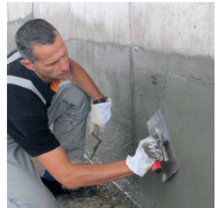
PCI Barraseal ist plastisch-geschmeidig. Poren und Vertiefungen werden leicht und schnell geschlossen.
